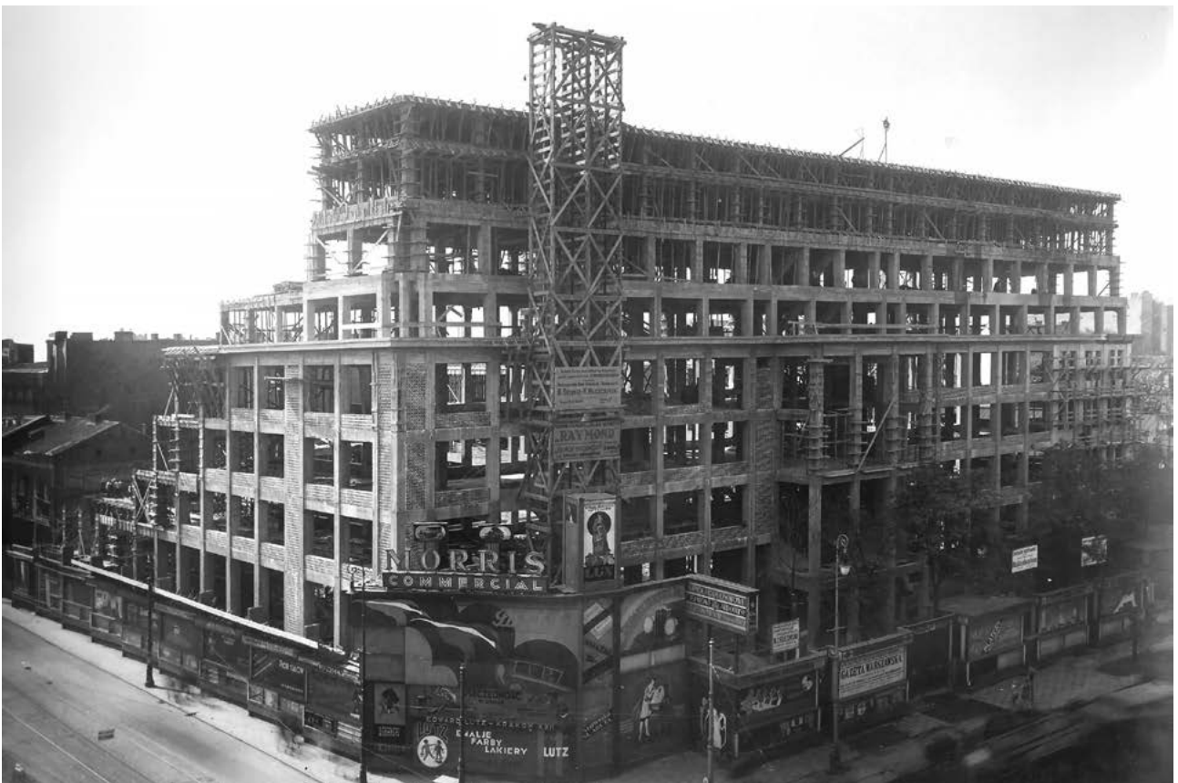
Budowa nowego gmachu BGK
