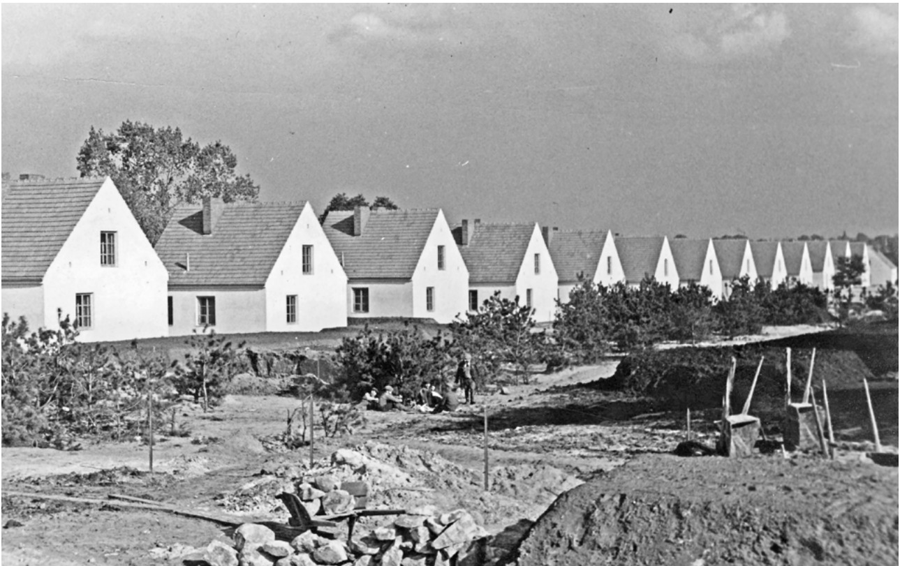
Budowa osiedla Banku Gospodarstwa Krajowego na Kole w Warszawie
