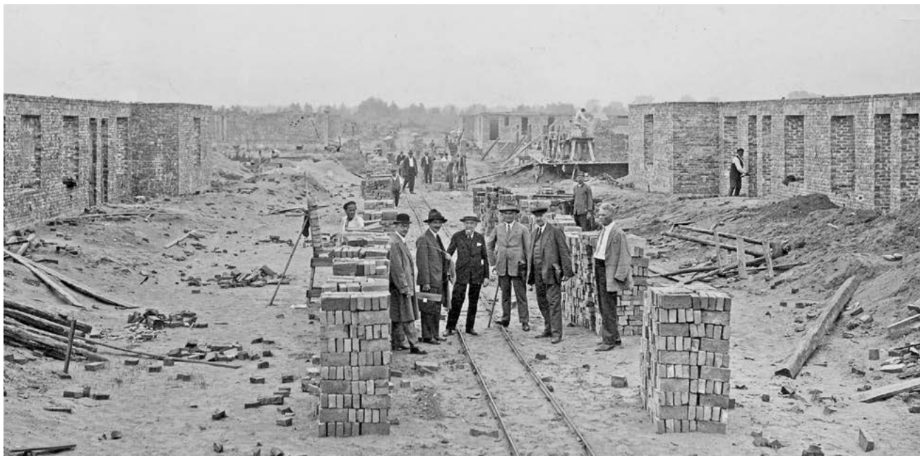
Budowa osiedla mieszkaniowego „Zdobycz Robotnicza” na Bielanych. Widoczna komisja ankietowa.
