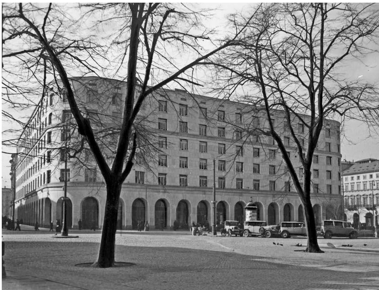
Budynek mieszkalny Wojskowego Funduszu Kwaterunkowego tzw. „Dom bez Kantów”.
