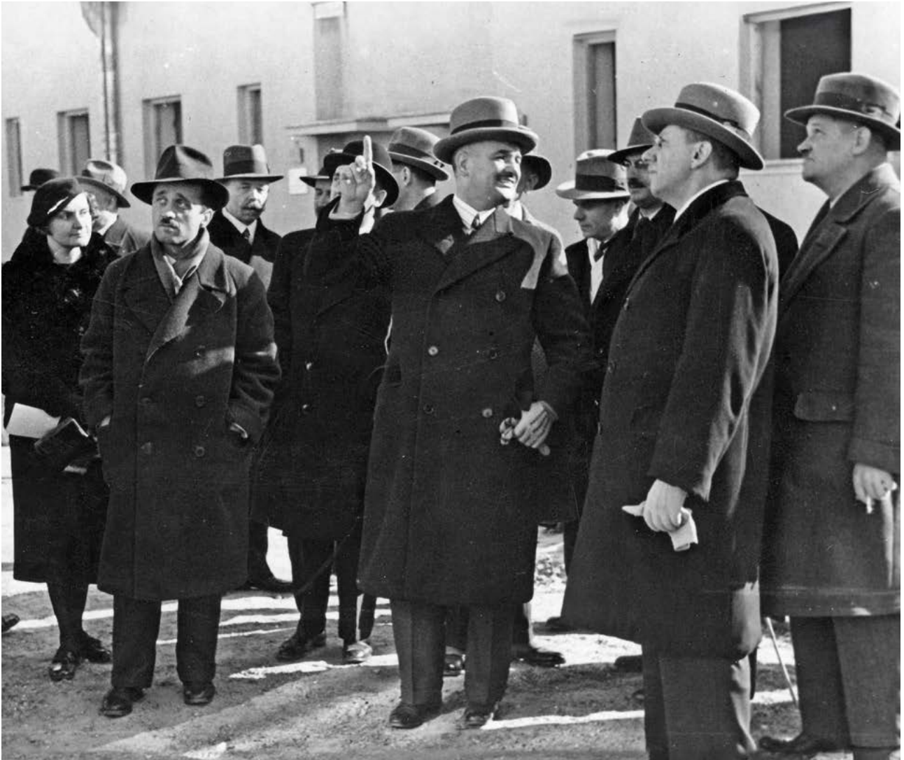
Roman Górecki zwiedza teren budowy osiedla.
