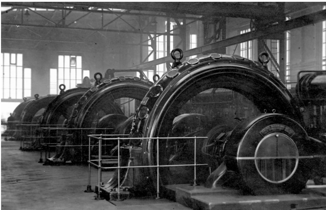
Państwowa Fabryka Związków Azotowych w Chorzowie
