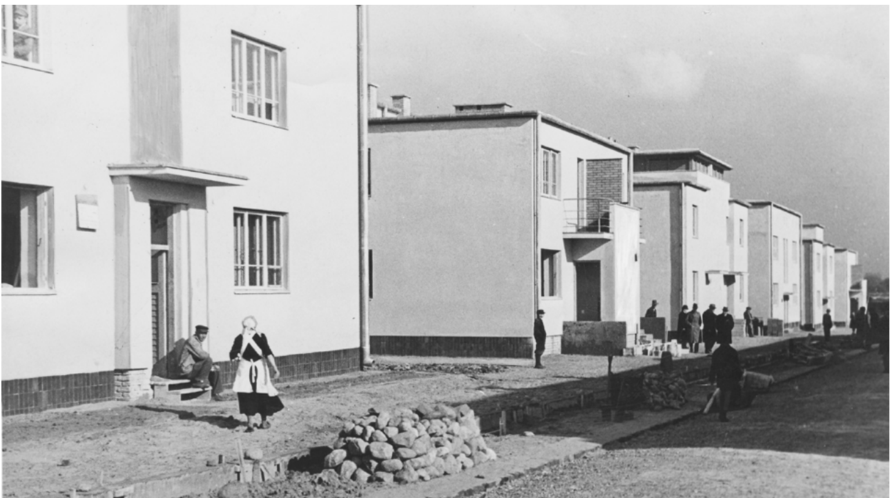
Budowa osiedla Banku Gospodarstwa Krajowego na Kole w Warszawie
